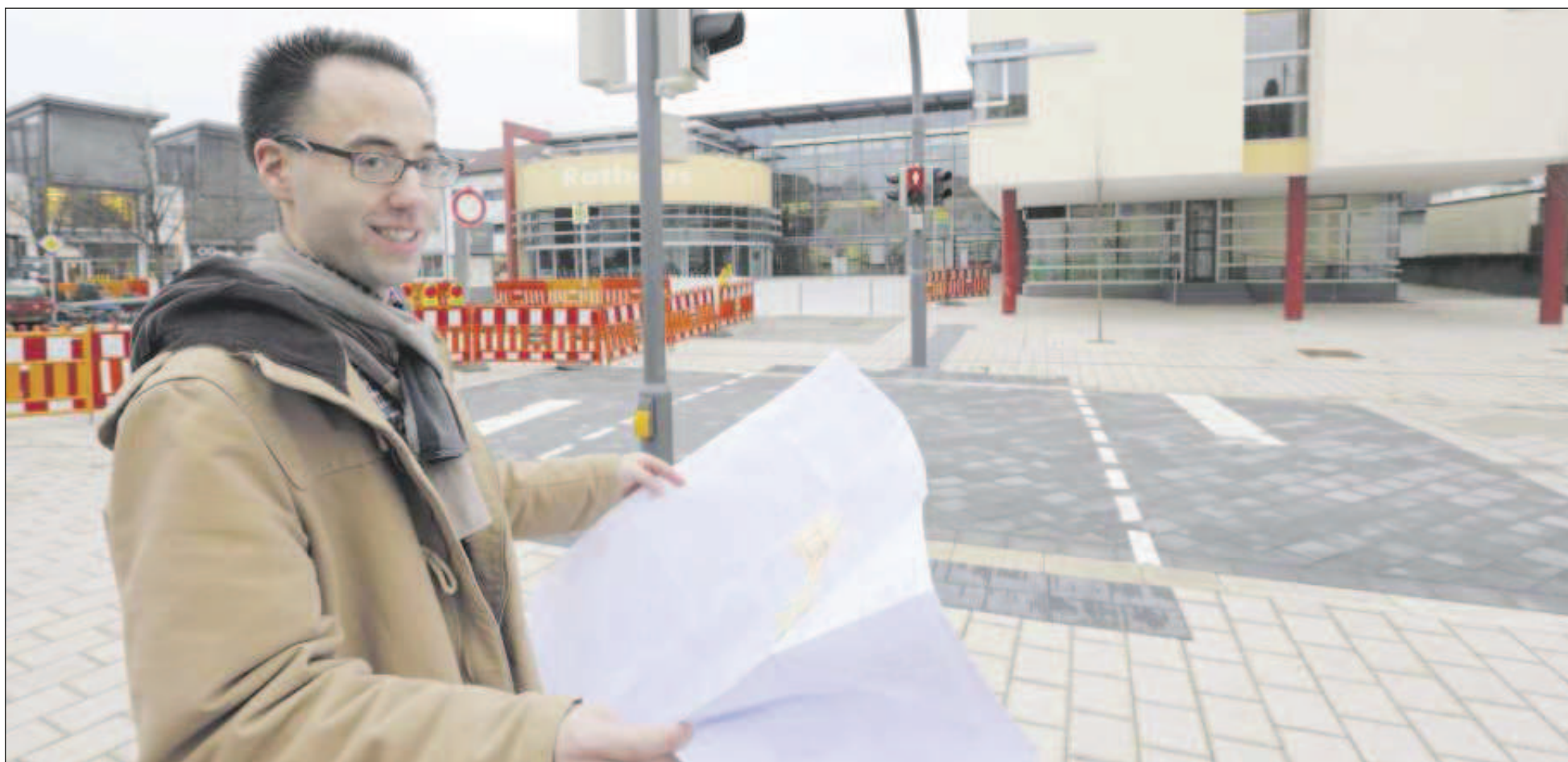
Mit Blick aufs Rathaus: Wo Bauamtsleiter René Schaal steht, werden künftig Bänke aufgestellt. Im Hintergrund sieht man die Baustelle für Restarbeiten für die neue Ortsdurchfahrt.
