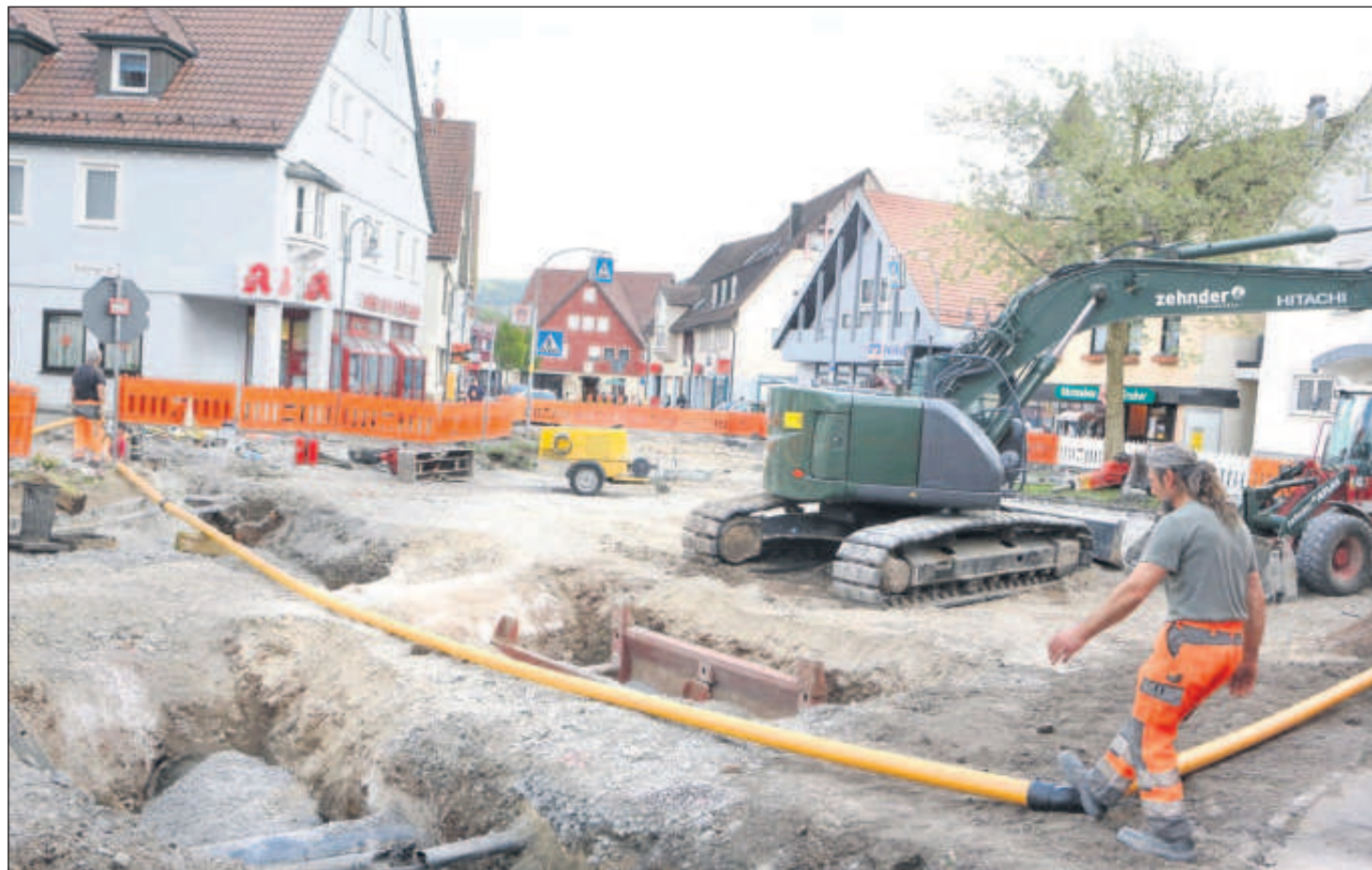
In der Rudersberger Ortsmitte haben weitere Bauarbeiten für die Neugestaltung der Ortsdurchfahrt begonnen.
