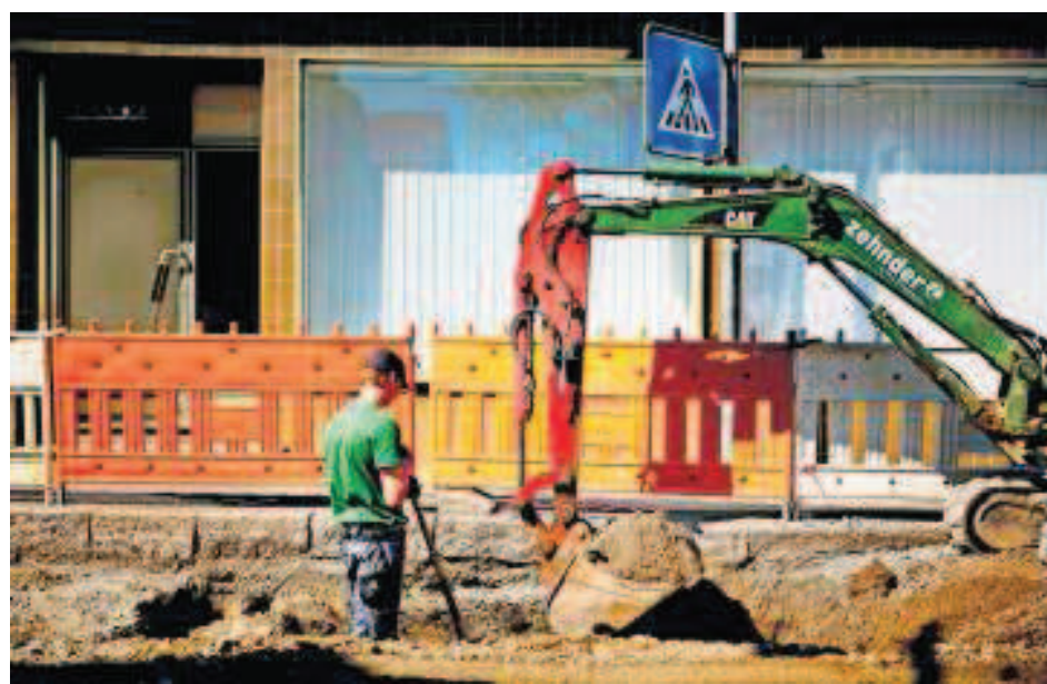
In der Rudersberger Ortsmitte wird bereits gebaggert. Foto: Gottfried Stoppel
